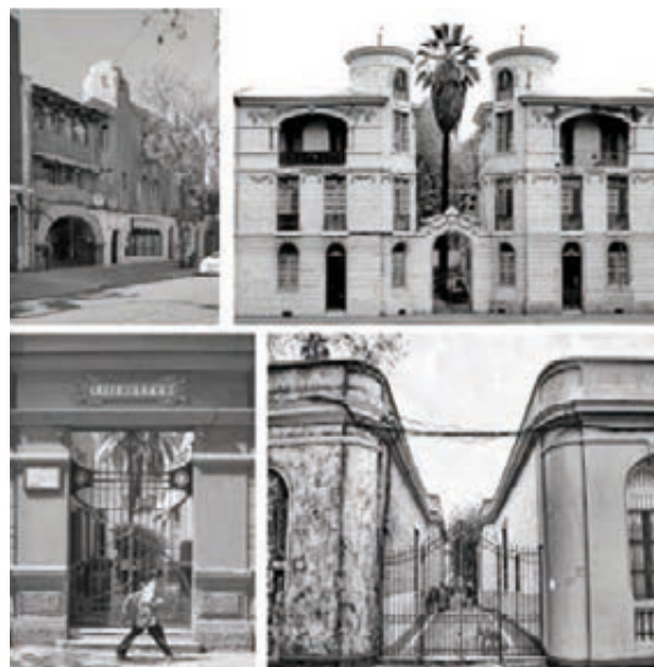
Fig. 4 Fachadas de Cites ( fuente Google)
