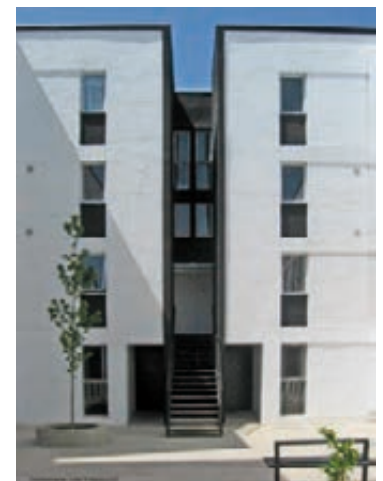
Fig 18 Detalle acceso departamentos
